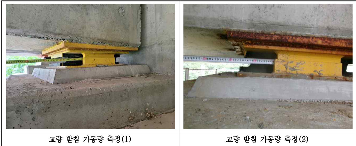
【사진 16.3.16】 교량받침 이동량 측정
