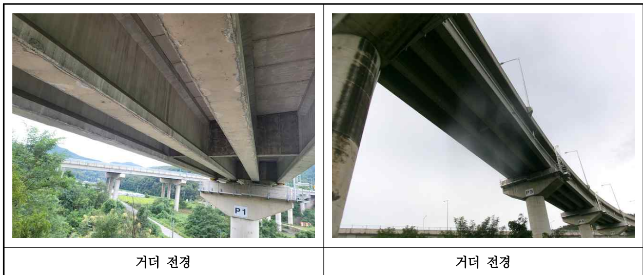
【사진 16.3.4】 거더 전경
