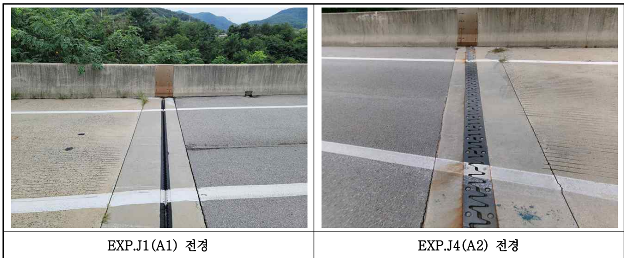
【사진 16.3.17】 신축이음장치 전경
