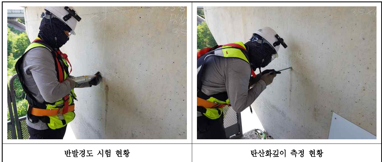
【사진 16.4.1】 콘크리트 내구성조사 현황
