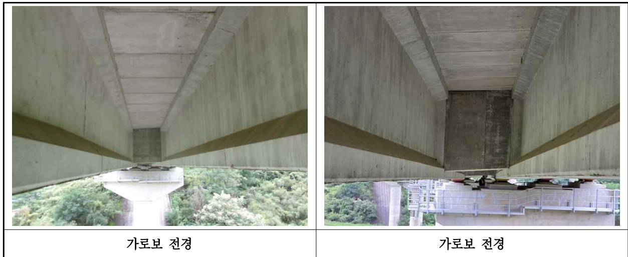
【사진 16.3.6】 가로보 전경
