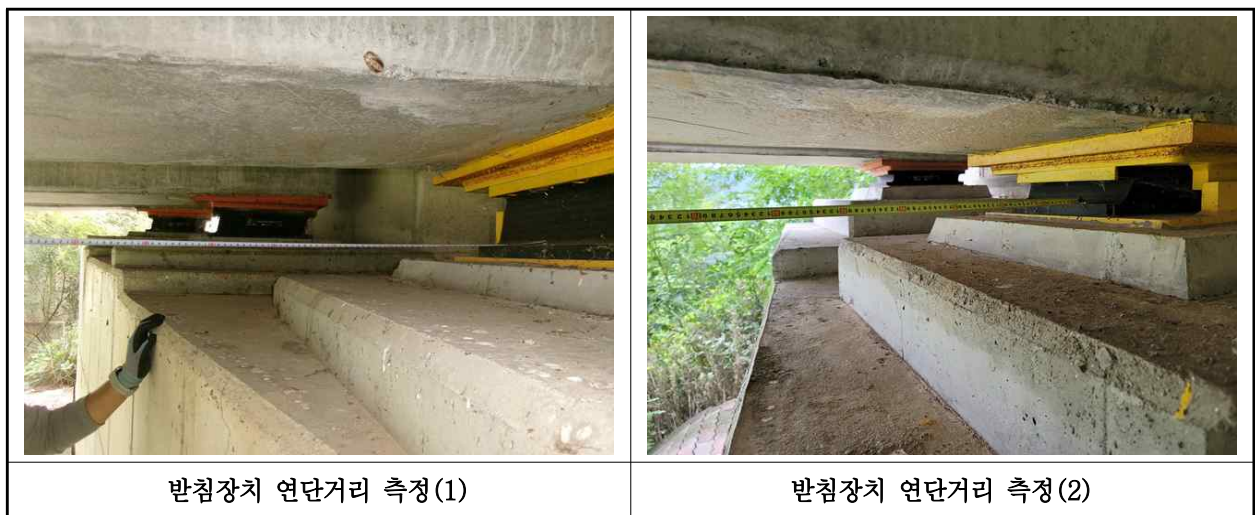
【사진 16.3.15】 교량받침장치 연단거리측정
