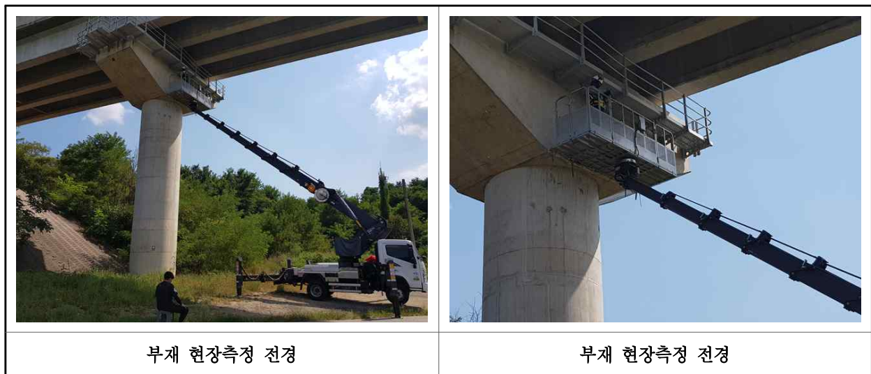
【사진 16.2.1】 부재 현장측정 전경
