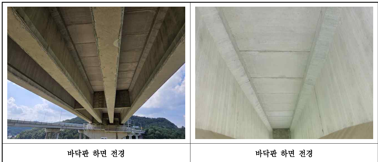
【사진 16.3.2】 바닥판하면 전경
