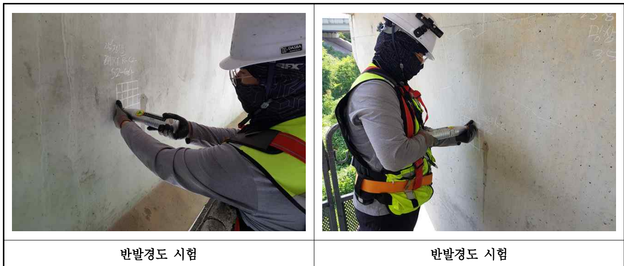
【사진 16.4.2】 반발경도시험 현장사진
