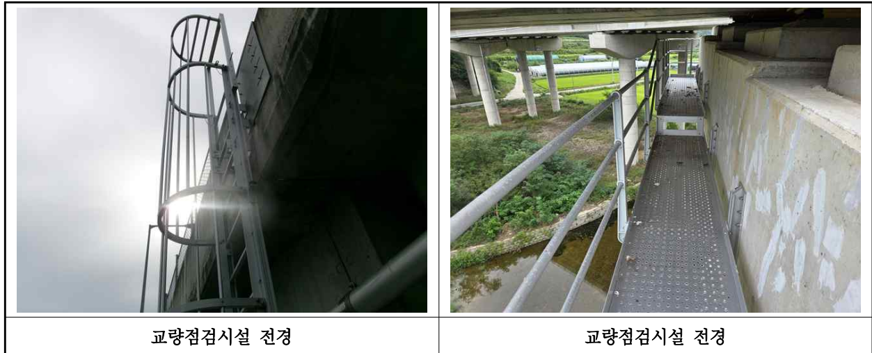
【사진 16.3.26】 교량 점검시설 전경
