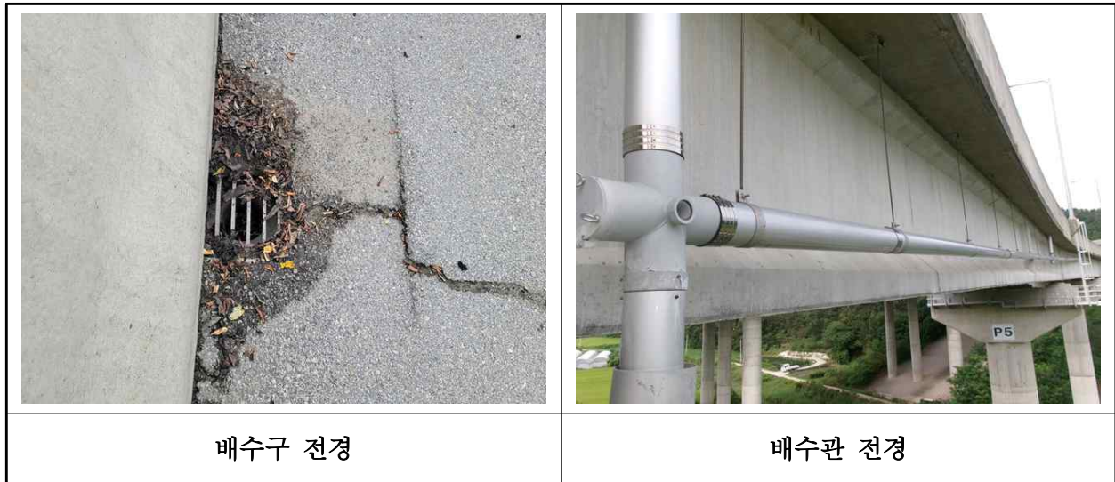
【사진 16.3.22】 배수시설 전경
