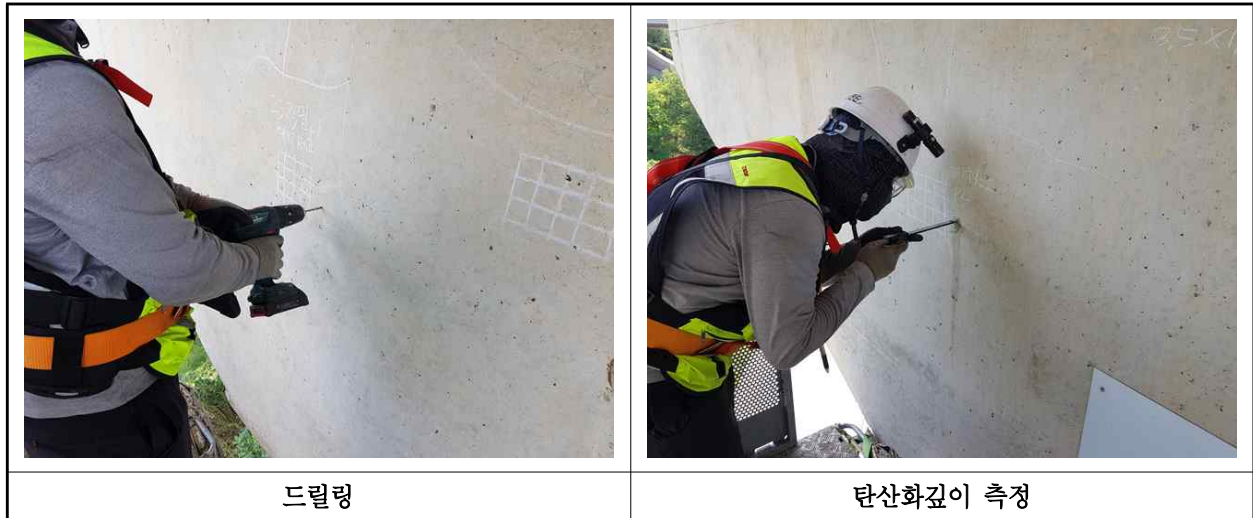
【사진 16.4.3】 탄산화 깊이 측정 현장사진
