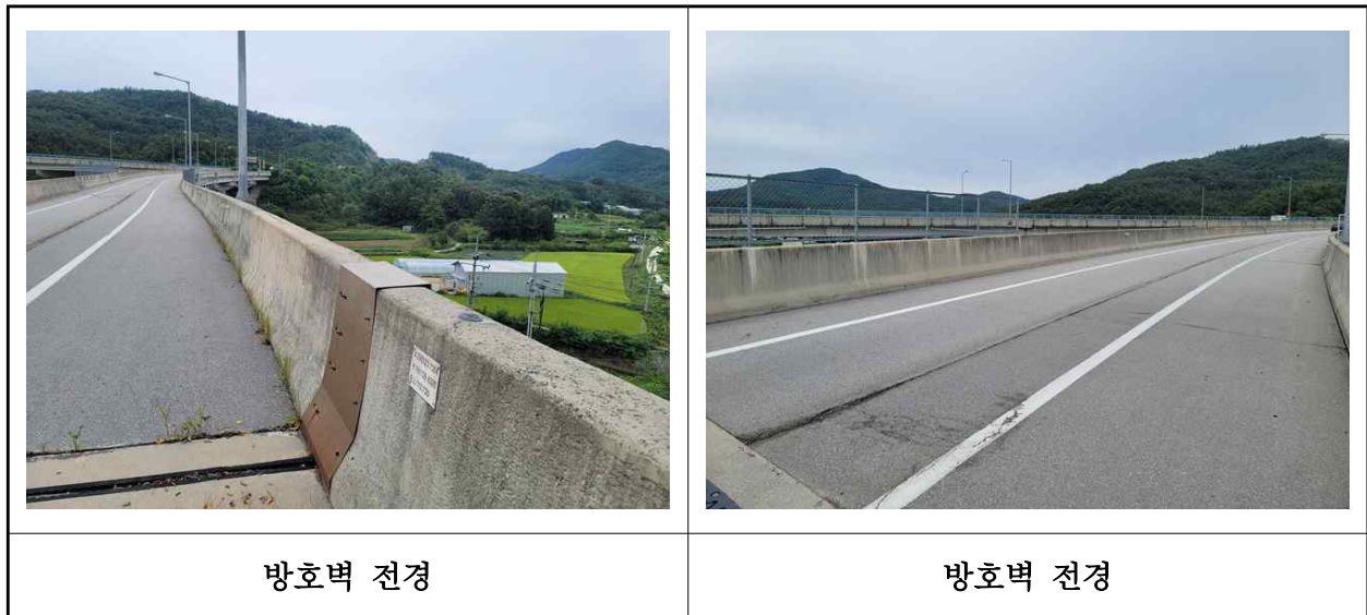
【사진 16.3.24】 방호벽 및 중앙분리대 전경
