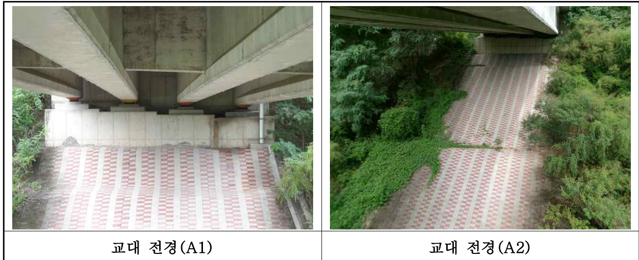
【사진 16.3.8】 교대 전경
