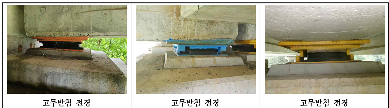
【사진 16.3.13】 교량받침 전경
